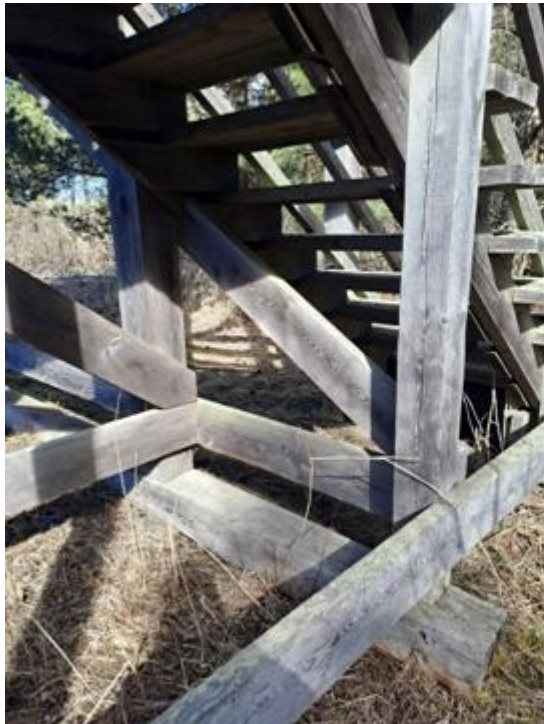
Kuva 81. Lintutornin tukirakenteet.
