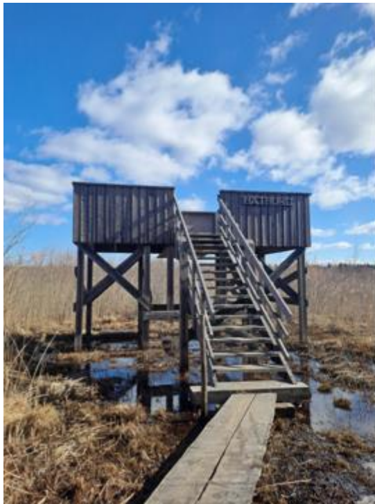
Kuva 103. Lintutornille johtaa pitkospuut.
