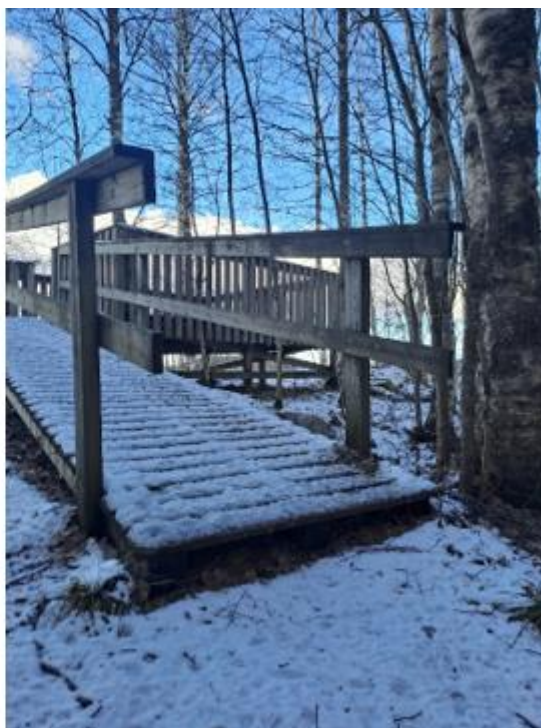
Kuva 8. Luontolavan rampin pykällys.
