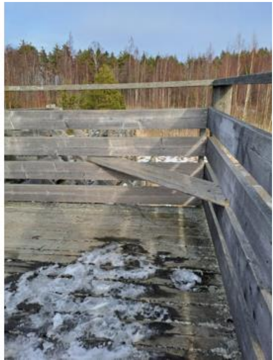
Kuva 67. Ylätasanteelle tehty penkki.
