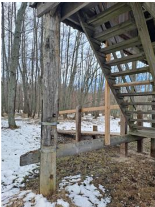
Kuva 54. Vahvistettu tukipylväs.
