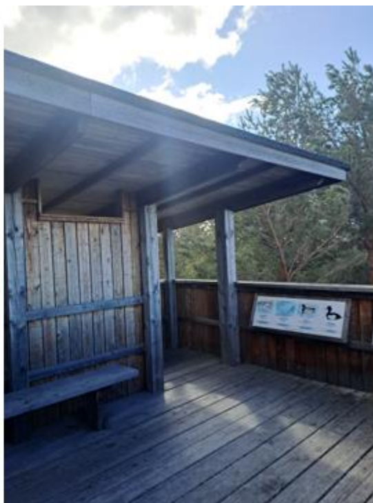
Kuva 80. Ylätasanteen osittainen katos.
