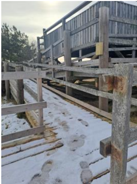
Kuva 24. Lavalle johtava pitkä ramppi.
