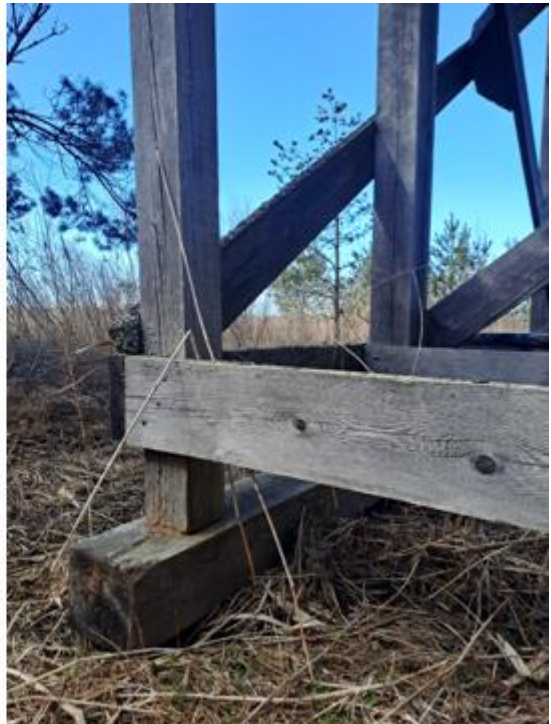
Kuva 82. Rakenteet ovat säilyneet hyvinä.
