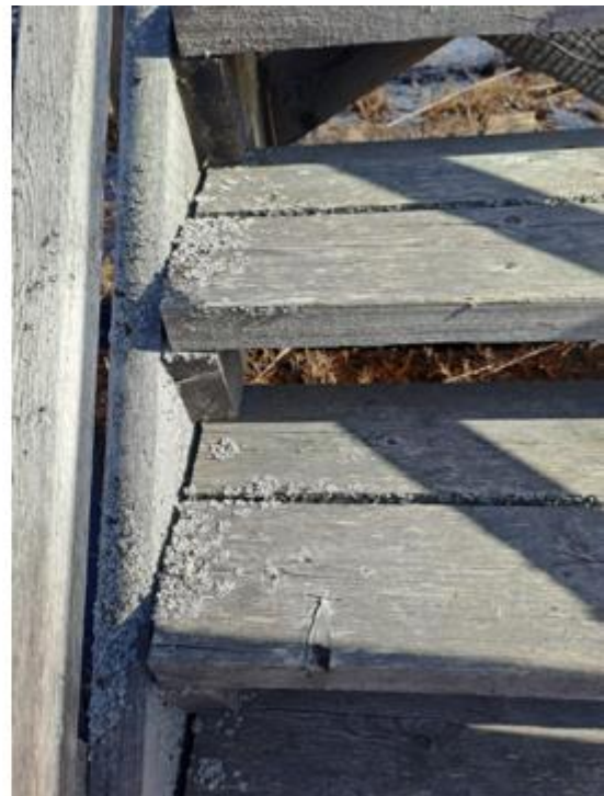
Kuva 106. Jäkälää rakenteissa.
