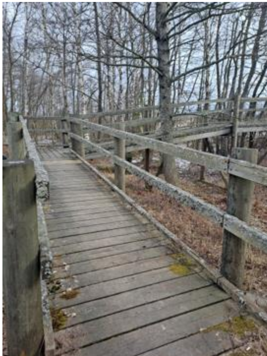
Kuva 43. Tornille johtava pitkä ramppi.
