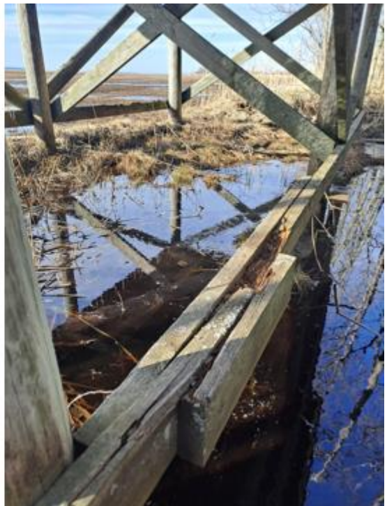
Kuva 90. Rakenteiden lahovaurioita.
