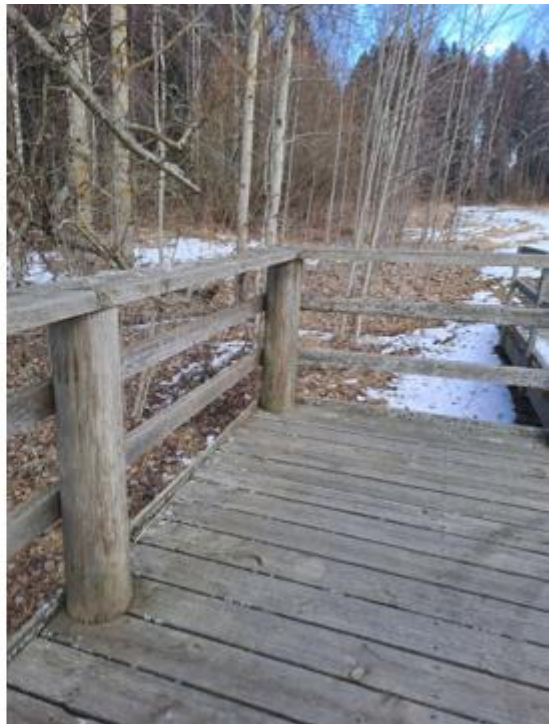
Kuva 61. Luontolavan kannen rakenteita.
