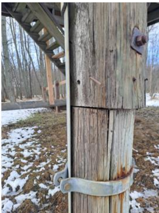
Kuva 55. Tukipylvään metallivanne.
