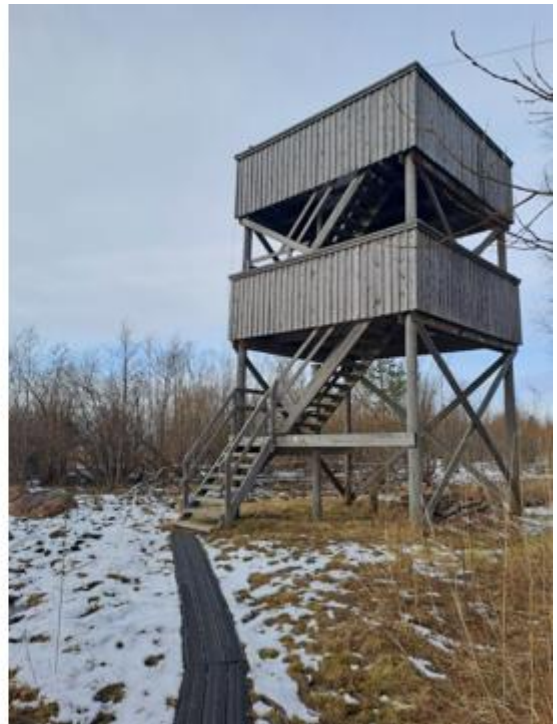
Kuva 71. Lintutornille johtaa pitkospuut.
